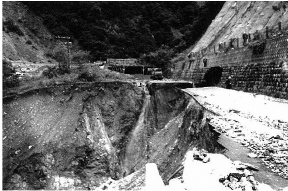
国道 156 号線の決壊（昭和 51 年豪雨）
