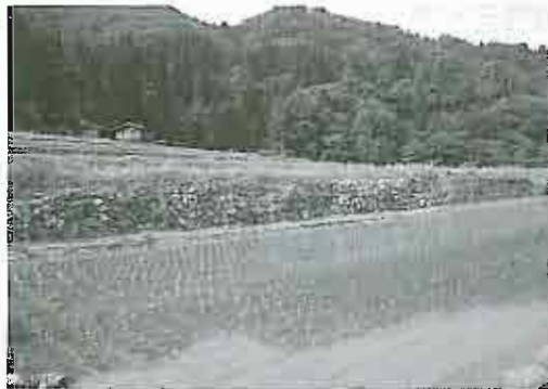
松田年春家 石積（修理前）
