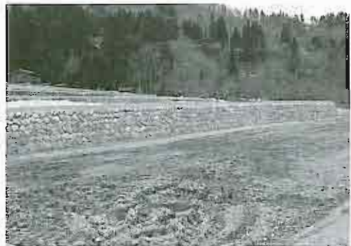
松田年春家 石積（修理後）
