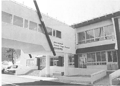
▲白川中学校を改修しました
