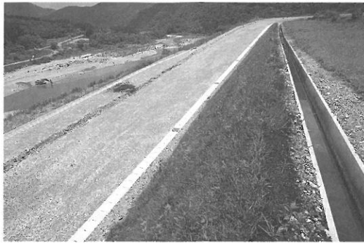
▲村道木谷・稗田線改良工事を行いました
