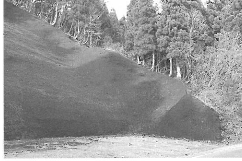
▲村道鳩谷馬狩線法面改修工事を行いました
