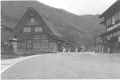
▲荻町地内の舗装・水路改修を行いました
