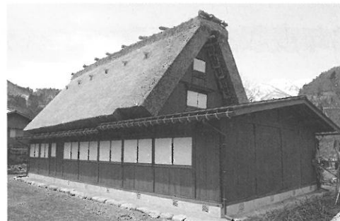
牧山徳蔵家（修理後）
