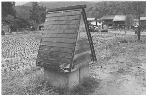
放水銃格納箱（取替前）
