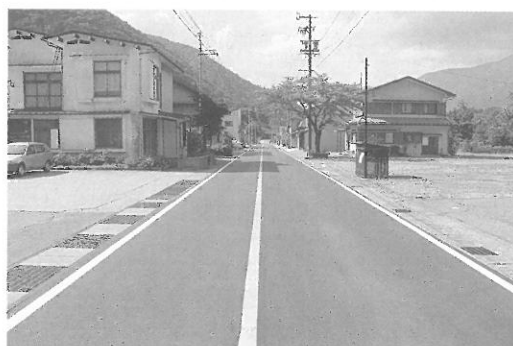
▲平瀬幹線の舗装補修整備
