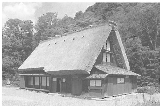
▲合掌造り民家園旧浅野家の改修整備
