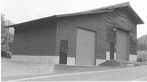
▲寺尾地内のライトアップ倉庫改修整備
