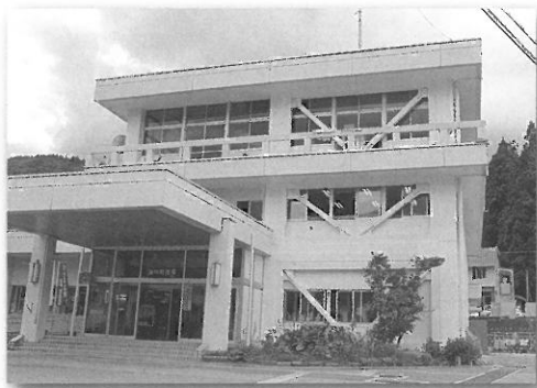
▲庁舎耐震補強改修事業
