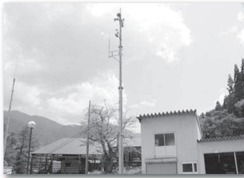
▲防災行政無線設備デジタル改修工事
