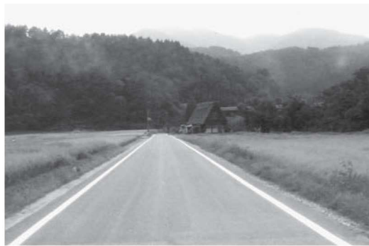
▲荻町中央幹線舗装補修工事
