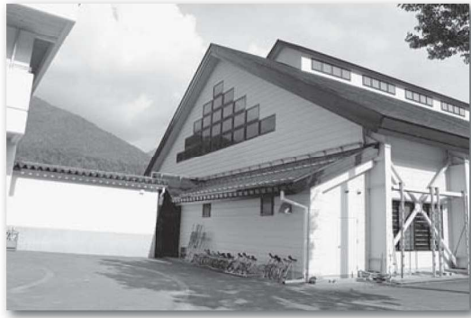
▲ふれあい体育館の屋根を改修しました
