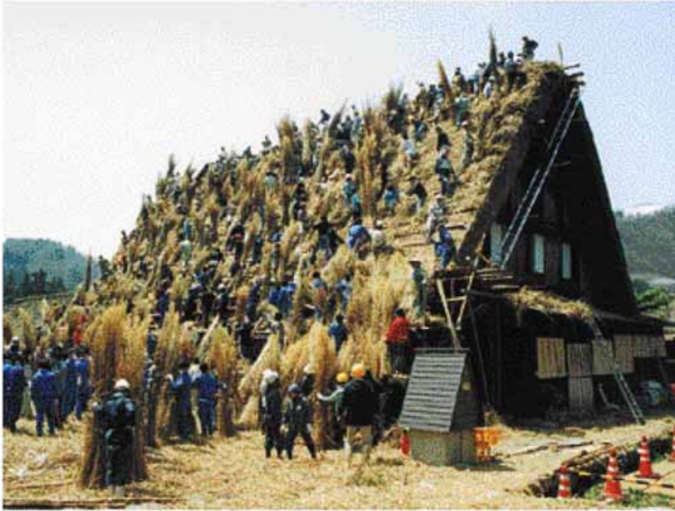
平成13年春、結による長瀬家屋根の葺き替え
