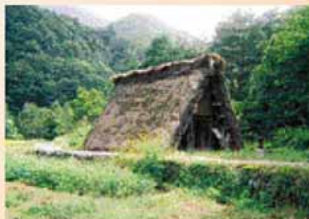
小屋のみの倉庫
