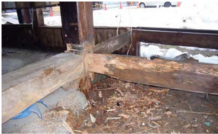
図3：破損状況 シロアリ被害
