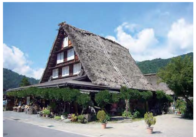
図6：修理前板谷家 道路側二間分がトタン落屋
