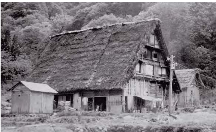
図5：移築前の正面 建物右側二間分が撤去されて移築された。今回はこの部分を復原する。
