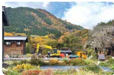
家屋解体作業の様子
