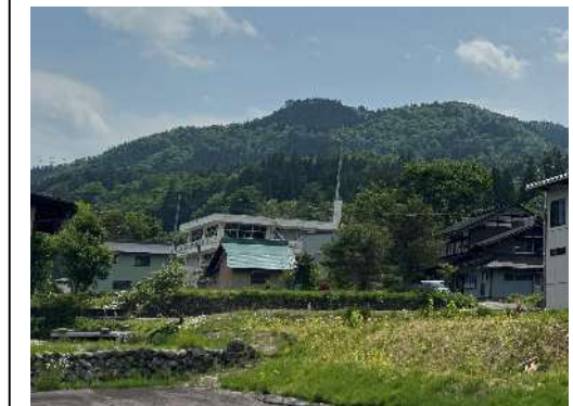
庁舎全景 2 (遠景)
